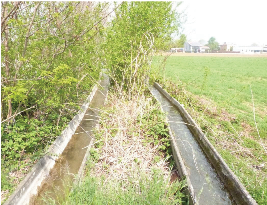
4 Vista delle canalette irrigue a correre a lato della strada.
